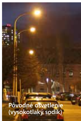
Pôvodné osvetlenie (vysokotlaký sodík)
